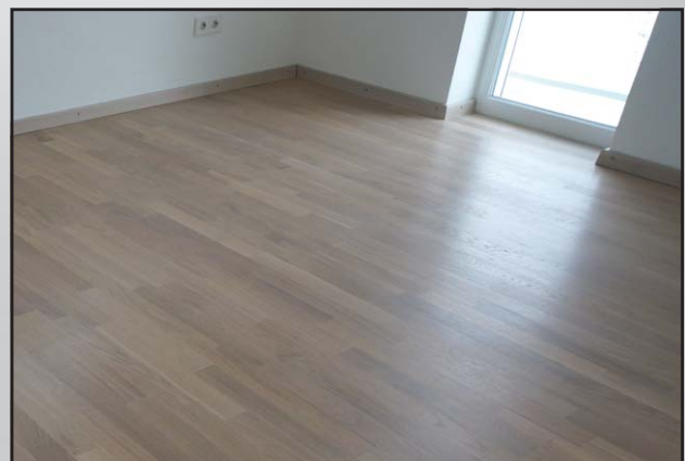
Abb. 11 Nach dem Einarbeiten des Coloröls mit einem Normalpad beige.
