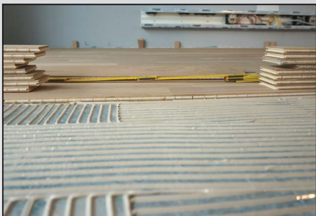
Abb. 7 Verkleben des Zweischichtparketts
