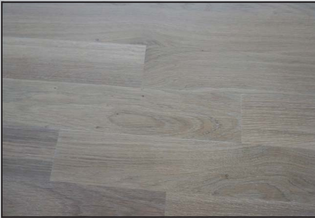
Abb. 8 Oberfläche nach dem ersten Schleifgang mit TRIO und Klettschleifscheibe Körnung 100.
