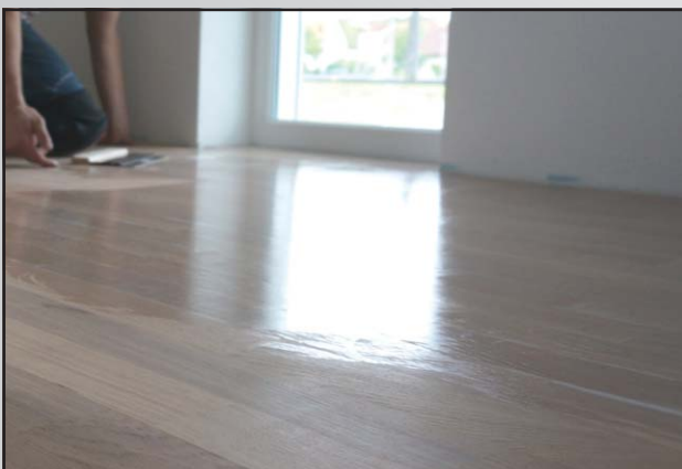
Abb. 10 Auftragen des Coloröls mit dem Spachtel.
