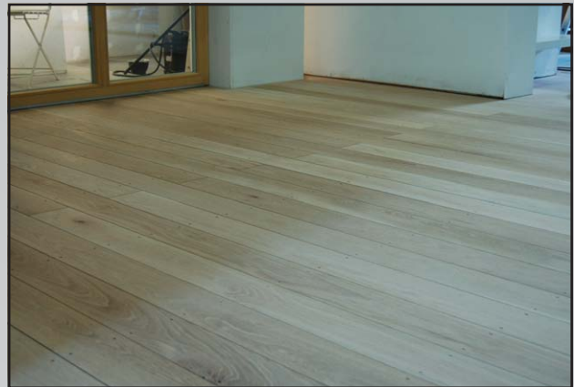
Abb. 10 Nach dem Vorschleif mit der HUMMEL®
