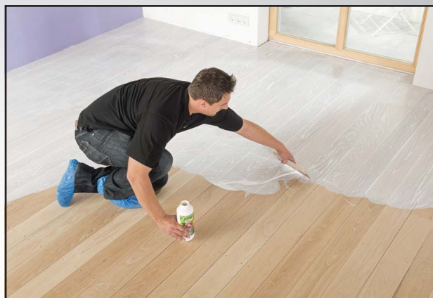
Abb. 13 Oberflächenbehandlung mit Coloröl
