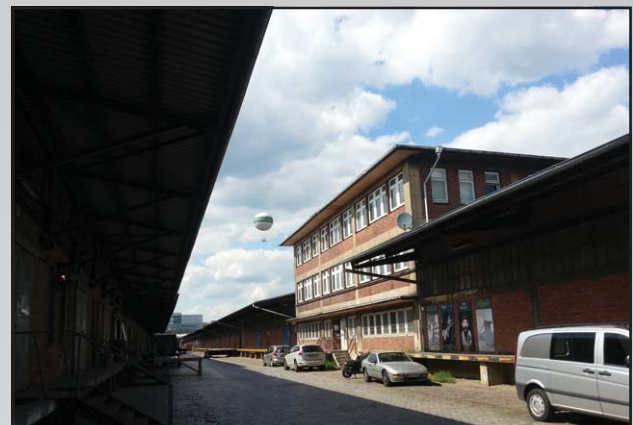
Abb. 4 Außenaufnahme des alten Speichergebäudes
