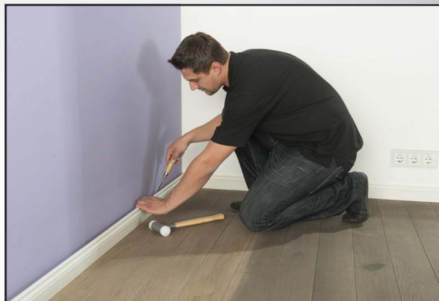
Abb. 6 Abnehmen der Sockelleisten
