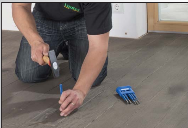
Abb. 7 Versenken hervorstehender Nägel
