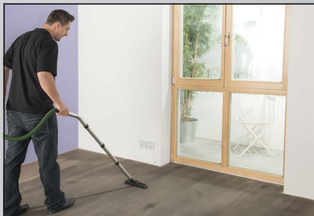
Abb. 8 Sehr wichtig: Immer vor jedem Schleifgang absaugen!
