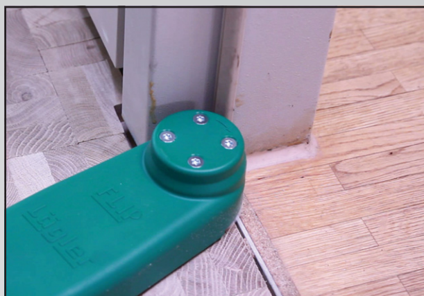
Abb. 15 Schleifen um die Türzargen mit dem Eckenvorsatz
