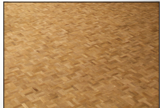
Abb. 11 Fertig verlegte Parkettfläche
