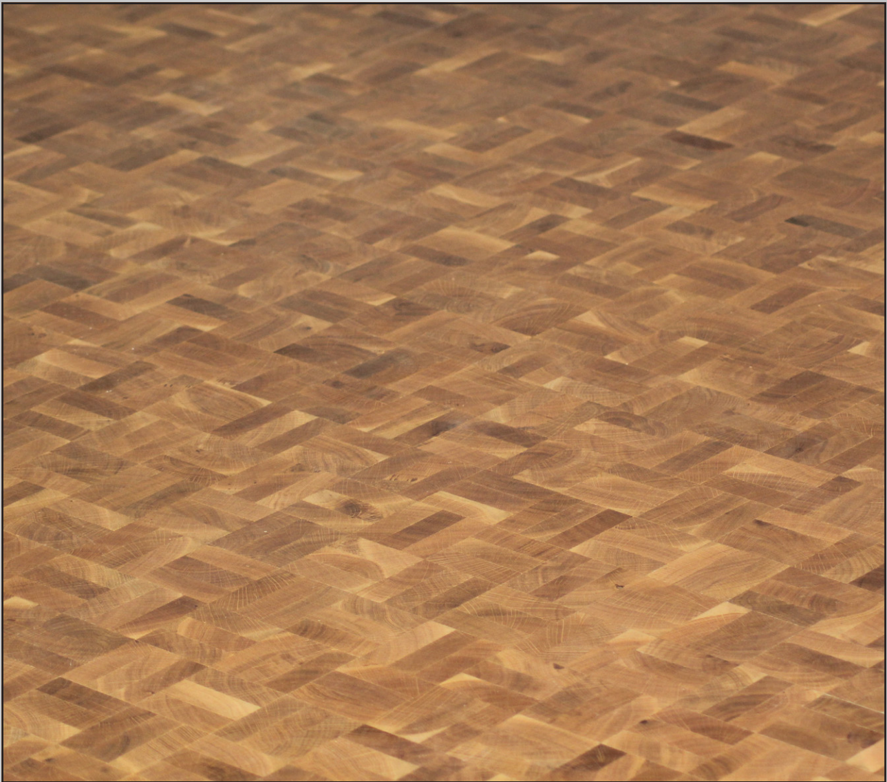
Abb. 16 Ergebnis der fertiggestellten Oberfläche: Ein Hirnholzparkett taugt nicht nur für Werkstattböden
