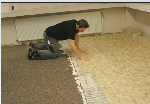
Abb. 10 Verkleben des neuen Hirnholzparketts
